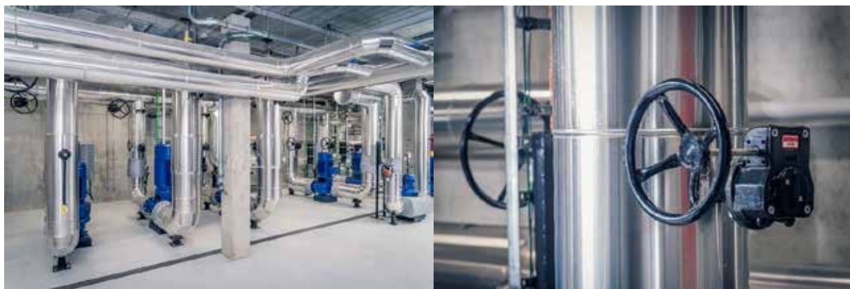
Zawory kulowe BROEN BALLOMAX kontrolujące przepływ wody grzewczej.
